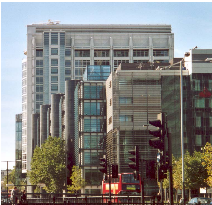
Photo : Construction de façades
